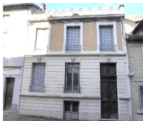
Maison bourgeoise début XXème avec sous-bassement sur 2 niveaux et marqué par sa modénature moulée (stuc ou ciment) Rue Saint-Martin-38_p83 - c1
