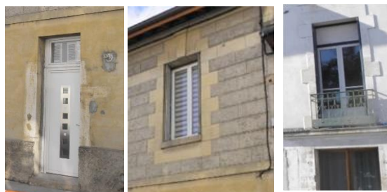
Dénaturation : modèle industriel de porte sur façade début XX ; fenêtre en pvc blanc à grand vitrage sans partition ; réduction de l'emprise d'origine de la fenêtre
