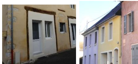
Dénaturation : aménagement d'origine modifié ouvertures retrécies, isolation par l'exterieur créant une surépaisseur de la façad, matériaux inadaptés dans les 2 cas.
