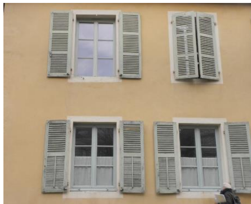
OUI : Fenêtres bois, neuves ou rénovées, partition du vitrage par petit bois et volet persienné avec mécanisme d'occultation en partie basse
