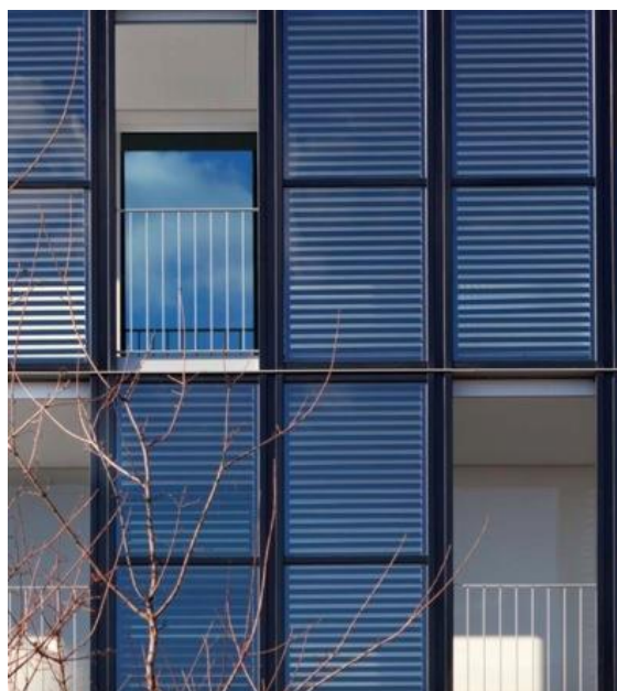
Agence Philippo- Kalt : immeuble de logements, Paris, avec vitrage isolant +capteur thermique (ECS) en façade
