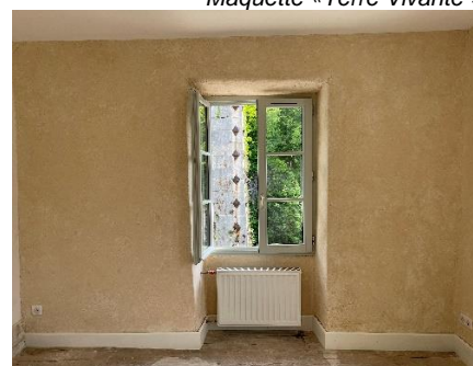
Parement avec finition enduit chaux lissé
