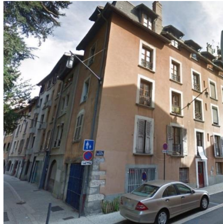
OUI immeuble isolé par l'extérieur avec un enduit à caractère isolant – (travaux 2017/2018 Grenoble)
