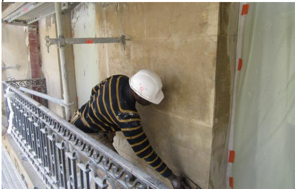
OUI- application d'un enduit isolant
