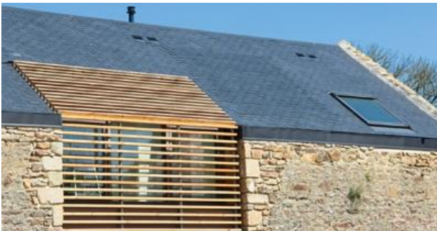
panneau solaire thermique invisible (sous ardoises) Thermoslate_solar_system
