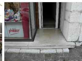
Dénaturation : déséquilibre de la composition des façades par rajouts d'éléments parasites en rez-de-chaussée, disparition des ouvertures d'origine, Recouvrement des belles dalles en pierre
