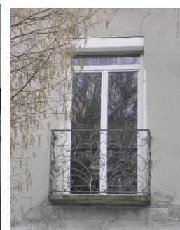
NON : Les coffrets de volet roulant diminuent la surface vitrée. Les montants en pvc blanc sont inadaptés au style architectural de ces bâtiments par leur dessin, par leur épaisseur et par leur couleur
