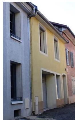
Maison de ville avant (à gauche) et après isolation par l'extérieur (Source : Malory CHERY)
