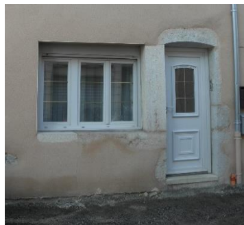
NON : Les coffrets de volet roulant diminuent la surface vitrée. Les montants en pvc blanc sont inadaptés au style architectural de ces bâtiments par leur dessin, par leur épaisseur et par leur couleur
