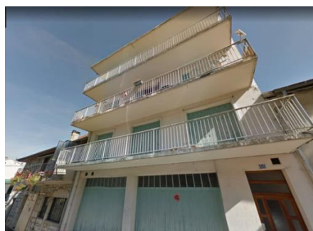
Av de la Résistance : balcons filants, porte d'entrée bois vitrée, portes de garage en bois avec imposte vitrée
