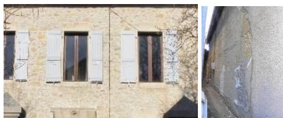
Dénaturation : décroulage ; enduit ciment sur mur en pisée
