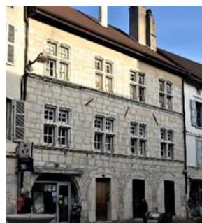
Maison noble : façade large, pierre de taille apparente pour les corniches ou bandeau et les encadrements de porte, les encadrements des fenêtres sont enduits et peints. Exception d'une façade entièrement en pierre de taille (33 Grande Rue)
