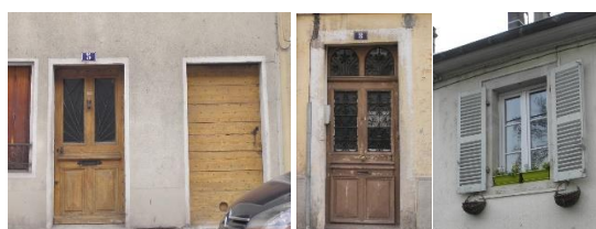
portes de différentes époques mais chacune en bois et de qualité, fenêtre à petit bois et volets à persiennes
