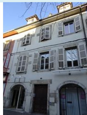
Demeure XVIIème composition régulière de la façade avec hiérarchisation des ouvertures, arc surbaissé en rez de chaussée, ou linteau droit pour le porche d'entrée Porte d'entrée avec vantaux bois à panneaux moulurés, pointe de diamant, et imposte ajourée. Grande rue-53_p714 -c2
