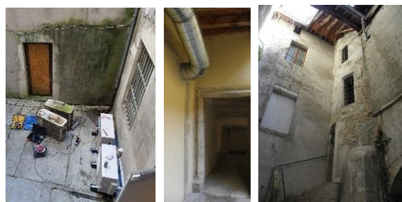
Dénaturation : Installation de bloc double flux, de gaine de ventilation ; volet roulant, fermeture de la coursive en parpaing de béton...
