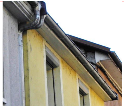
NON : diminution de la profondeur de la rive de toit due à l'isolation extérieur
