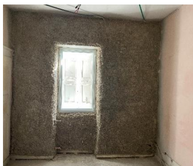
projection de l'isolant chaux chanvre
