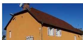
Dénaturation : suppression du coyaux et tuiles de grande dimension, ce qui ne permet pas d'épouser les déformations du bâti existant
